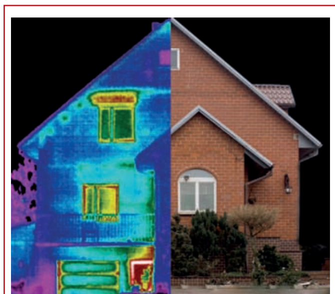
Rys. 7. Badanie szczelności budynku kamera termowizyjną
