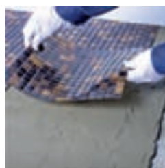
9. Ułożenie płytek podłogowych
