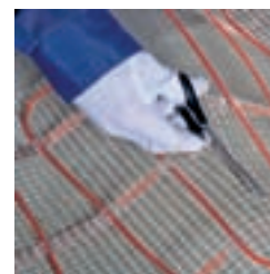
2. Nacięcie maty w miejscu zgięcia (zmiany kierunku) jej ułożenia
