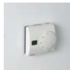
10. Zamontowanie regulatora temperatury na ścianie
