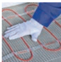
7. Finalne ułożenie i wyrównanie całej maty na wylewce
