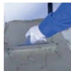
8. Rozprowadzenie zaprawy klejowej bezpośrednio na przymocowanej do posadzki maty
