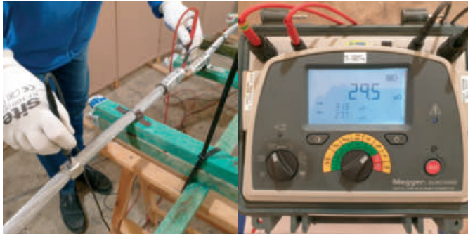
Rys. 7 Pomiar rezystancji zaprasowanej końcówki wykonywany po próbie cyklicznego nagrzewania i chłodzenia
